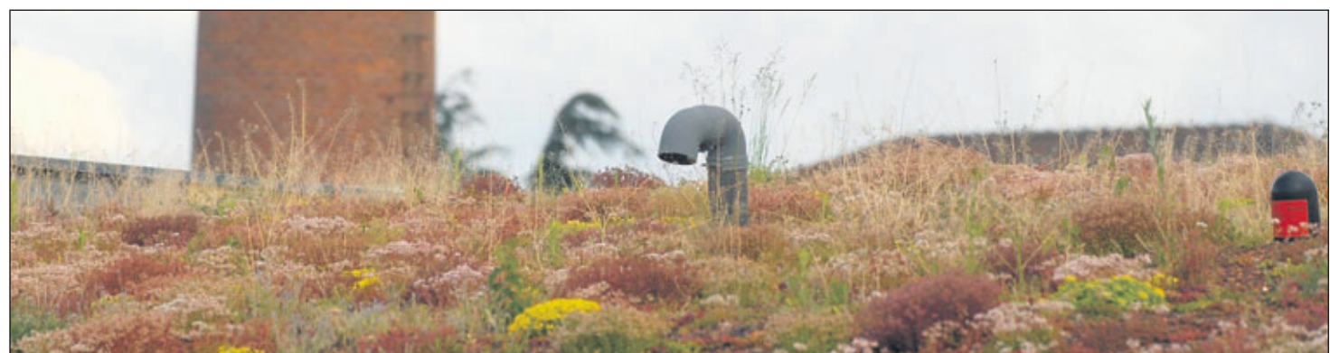
Auf den Dächern des Mehrgenerationenhauses wuchern Kräuter auf einer dünnen Substratschicht. Sie sollen die Isolationsfähigkeit des Daches erheblich verbessern.
